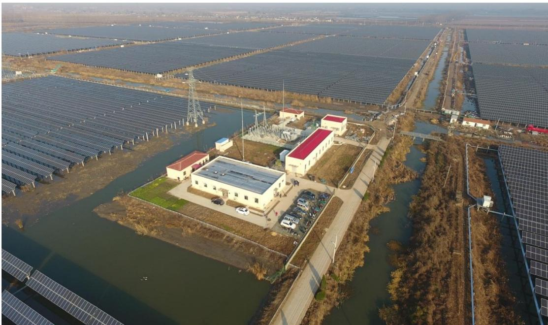
扬州艳阳天新能源有限公司利用 3,000 亩左右的鱼塘，完成了 108 兆瓦渔光互补光伏电站和 4 兆瓦渔光互补光伏电站。
