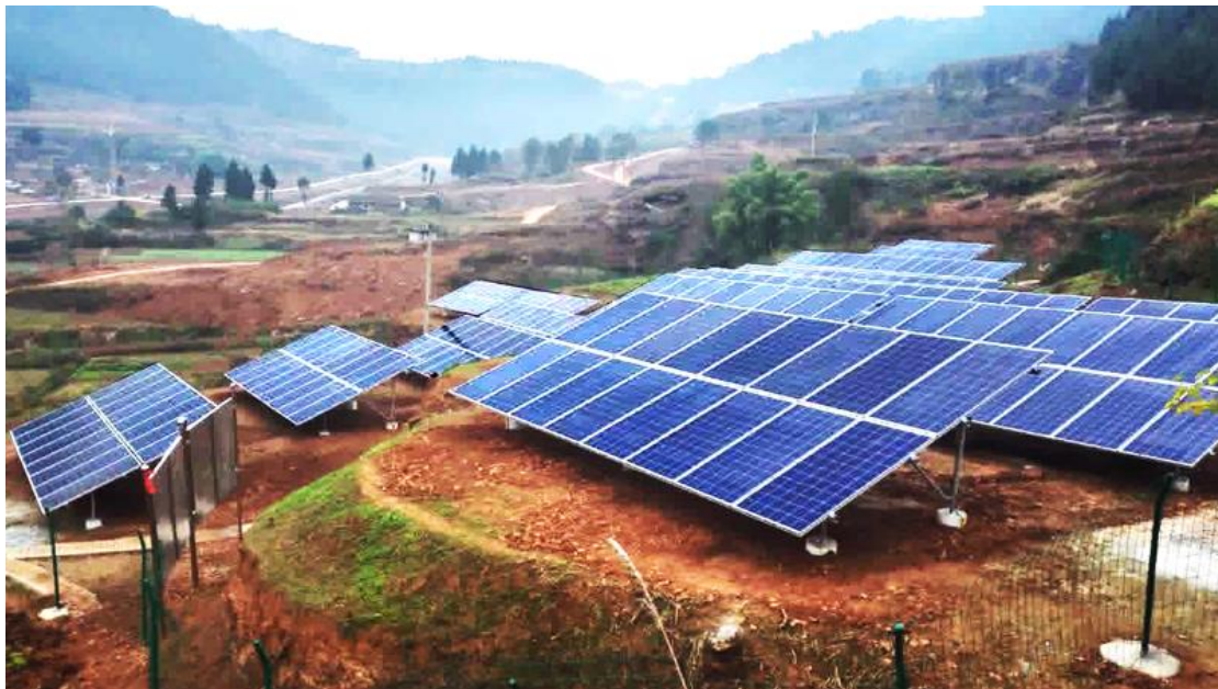
图：扶贫电站项目
