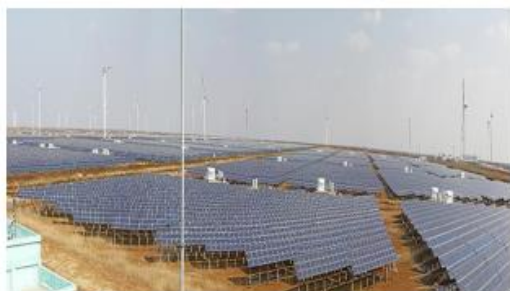
江苏响水 120 兆瓦渔光互补电站
