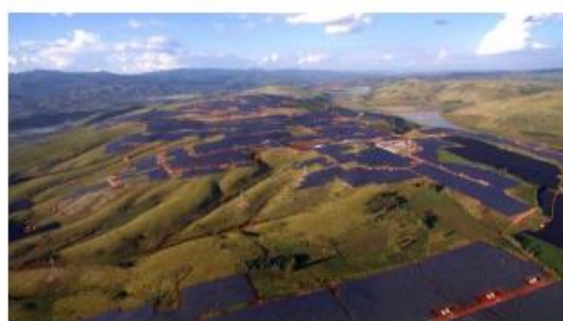
云南建水 300 兆瓦电站
