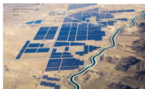
美国加州 106MW 项目
