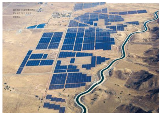
美国加州 106MW 项目
