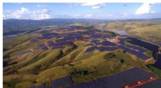
云南建水 300 兆瓦电站
