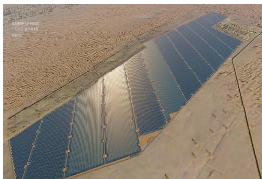
阿联酋 1177MW 项目
