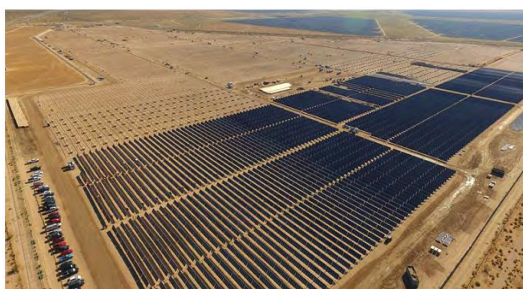
美国加利福尼亚州 107MW 项目
