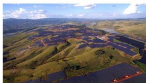
云南建水 300 兆瓦电站
