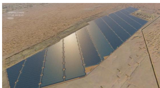
阿联酋 1177MW 项目
