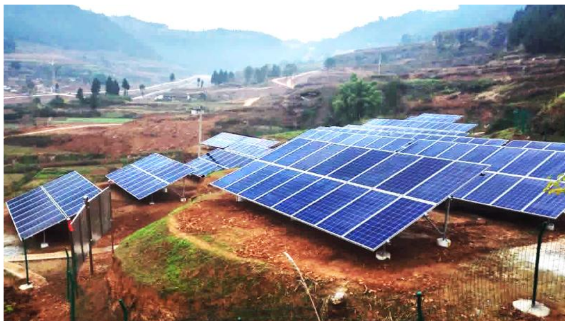
图：扶贫电站项目
