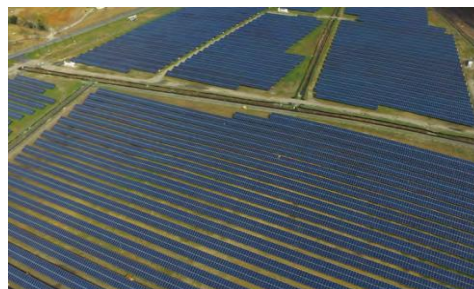
美国北卡罗来纳州 28MW 项目
