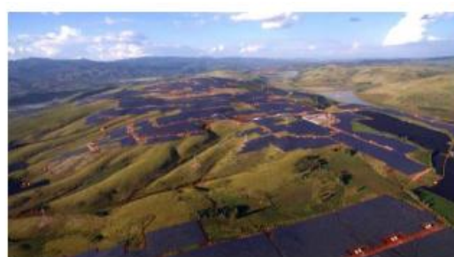
云南建水 300 兆瓦电站
