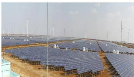
江苏响水 120 兆瓦渔光互补电站
