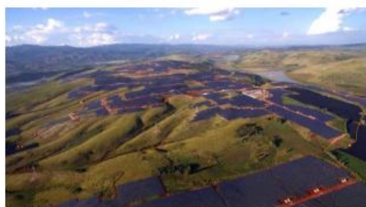
云南建水 300 兆瓦电站
