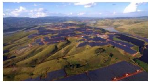
云南建水 300 兆瓦电站
