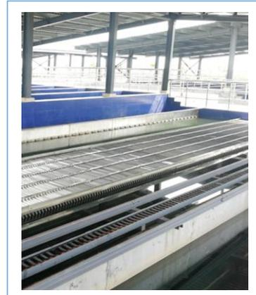
2019年4月，湖北枝江市仙女水厂新建项目建成投产，总规模设计10万吨/日，采用水平管高效沉淀池，达到沉淀池出0.4NTU的优质效果。
