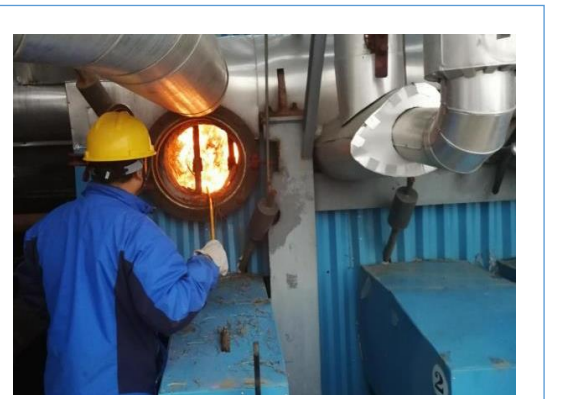
江苏宏东生物质能热电有限公司 2#锅炉点火烘煮炉
