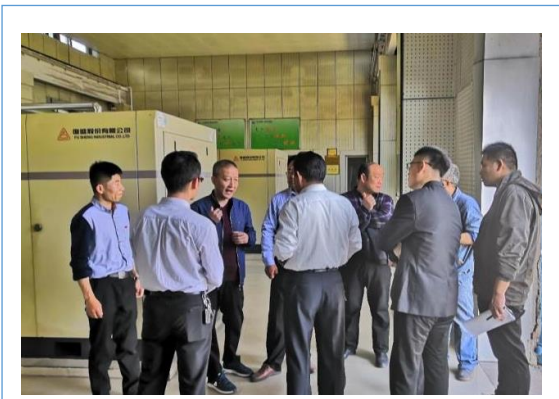
田陈煤矿余热利用项目 二期工程顺利验收
