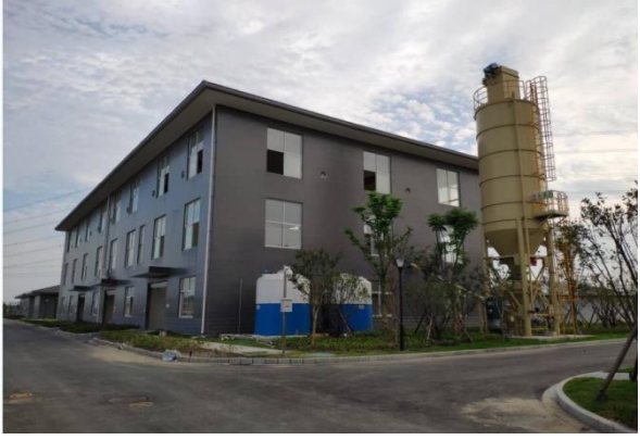
常州滨湖项目完成调试 工作
