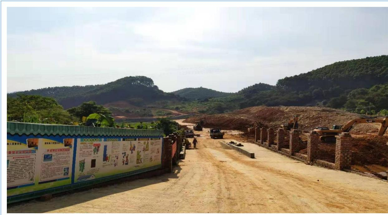
2019 年 3 月，公司下属东笋水厂改建工程顺利开工。项目建设内容包括新建一座净水厂，日处理量为近期 5 万立方米/天，远期 15 万立方米/天，并配套建设两条 DN1000 场外输水管道，总长 3.6 公里,项目总投资 1.3 亿元。该水厂采用最新的自动化净水工艺，供水生产安全及净水效率得到大幅提高。
