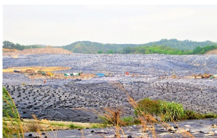
垃圾填埋覆盖
