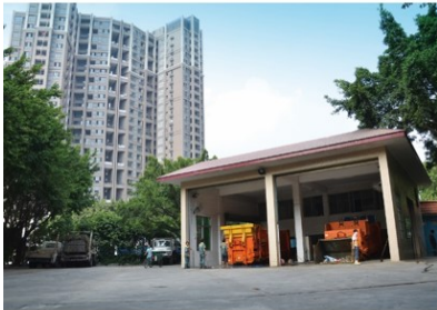
垃圾压缩中转站全貌
