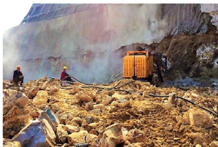
边坡支护施工
