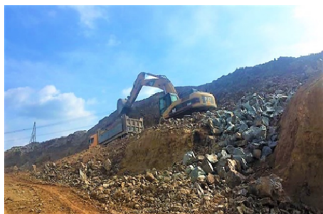
土石方开挖施工
