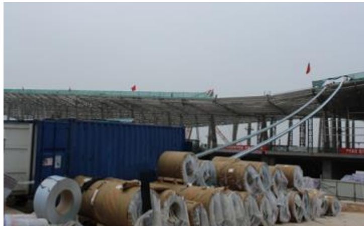
工地现场屋面板生产高空传输工艺图
