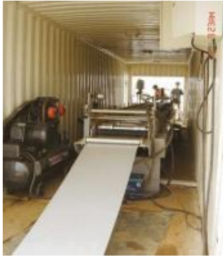
现场生产进料口
