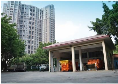
垃圾压缩中转站全貌
