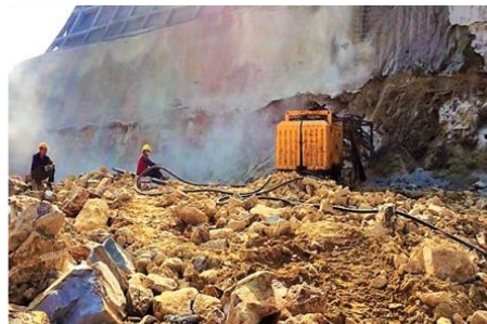
边坡支护施工
