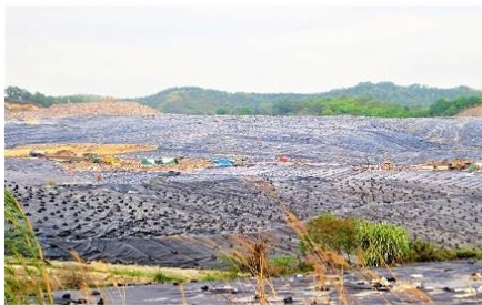
垃圾填埋覆盖
