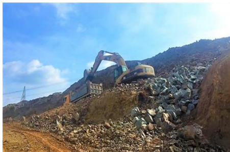
土石方开挖施工
