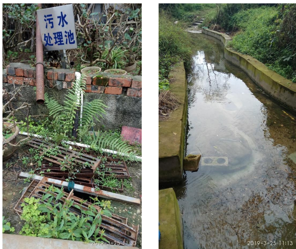
图 3-5 污水处理池及水渠现状
