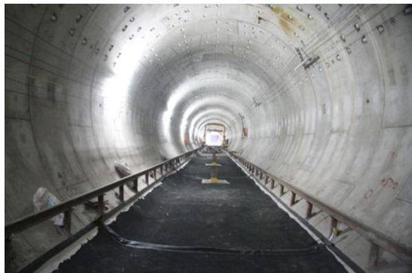
隔离式橡胶减振垫使用效果图
