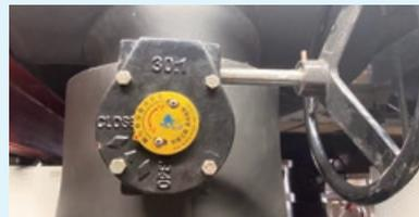
调整冷冻水循环泵出口阀门开度，降低水泵运行电流
