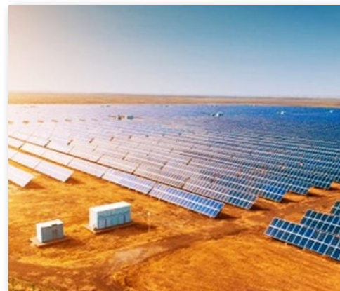
苏州中来光伏新材股份有限公司光伏发电项目
