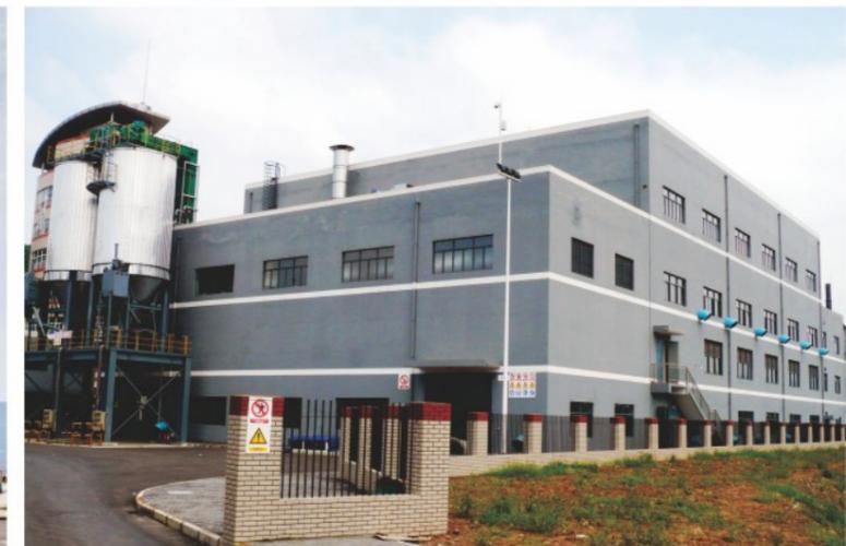
▲ 唐家沱污泥干化项目占地50亩,采用InnoDry干化技术,设计日处理污泥240吨(含水率80%),经过干化后污泥含水率降为10%。
