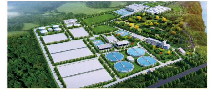
西南航空港组团工业集中发展区第六期工业污水处理厂项目鸟瞰图
