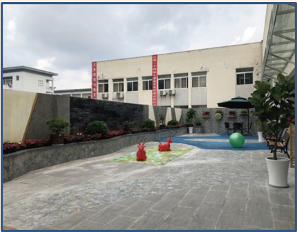
康复室项目竣工后
