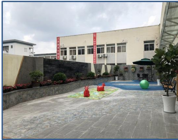
康复室项目竣工后
