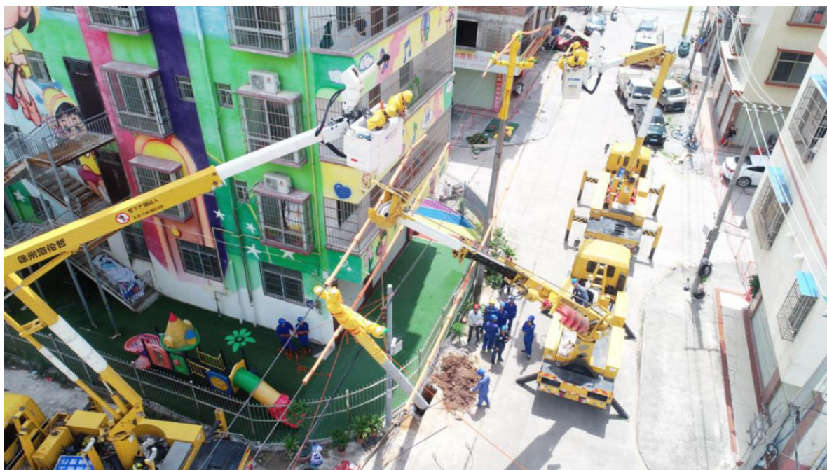
绝缘斗臂车和线杆综合作业车钦州供电局带电立杆换杆作业场景
