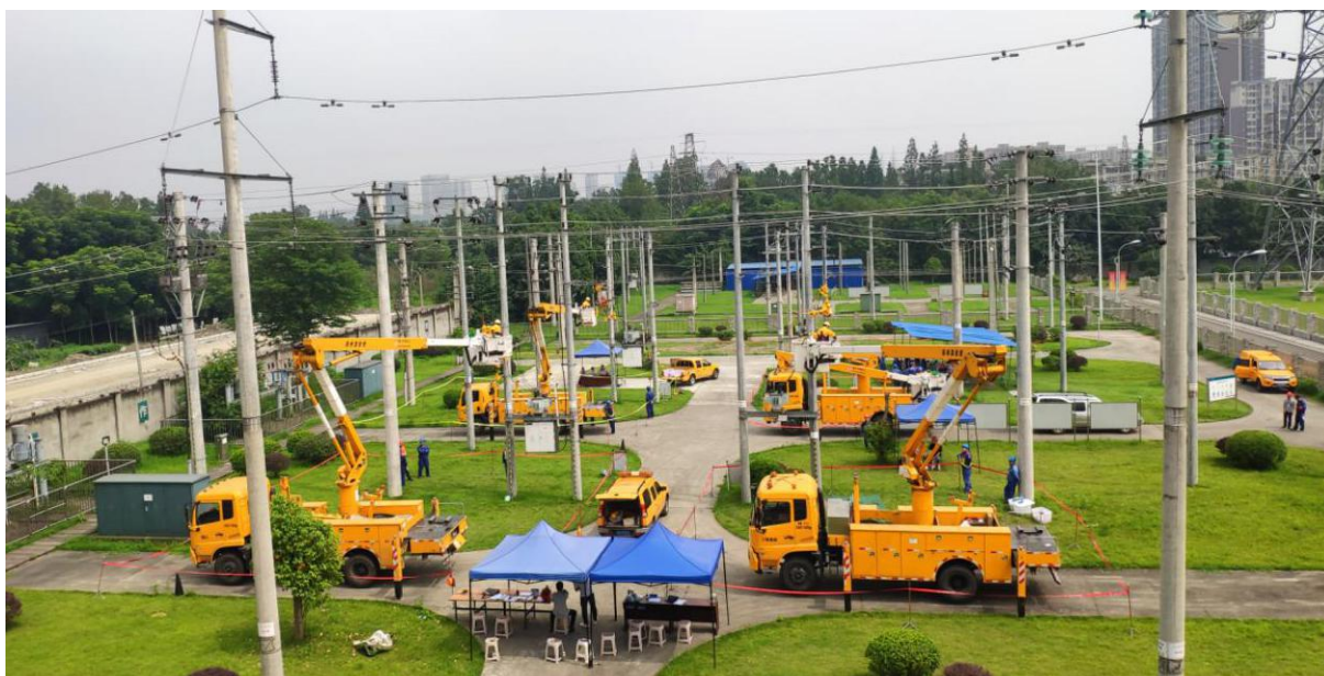
18 米绝缘斗臂车成都供电公司带电检修技能大赛工作场景
