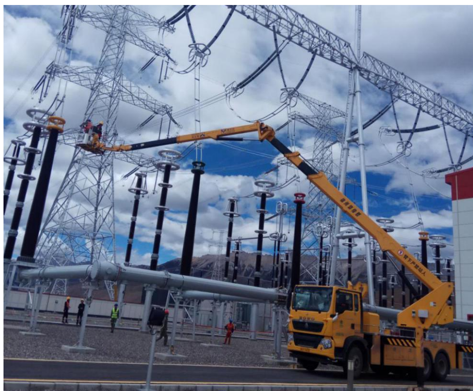
35 米混合臂高空作业车西藏左贡开关站作业场景
