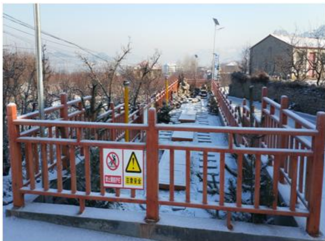
穆家小学污水站
