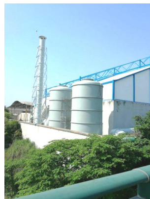
璜塘污水厂除臭加盖工程
