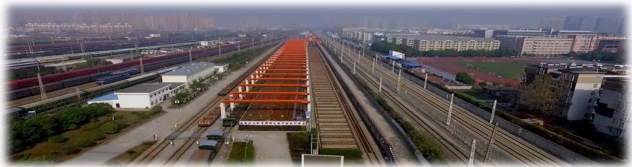
钢轨焊轨基地系统
