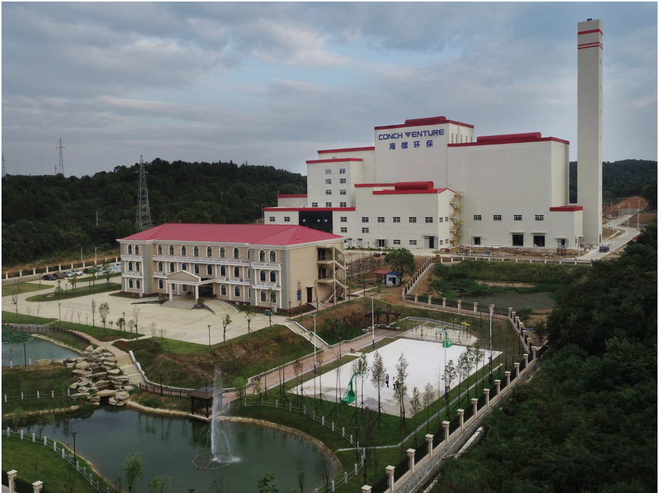
(圖為：澧縣海創爐排垃圾發電項目)
