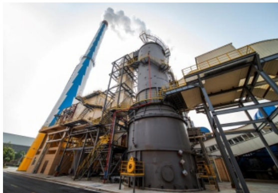
物产环能新嘉爱斯公司燃煤烟气污染物超低排放设施
