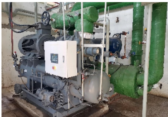
物产化工江苏科本公司新增制冷机组运用峰谷电能
