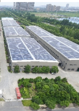
中大实业园区光伏发电项目
