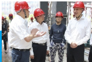
宋宏炯总裁检查金华人民医院在建工地
