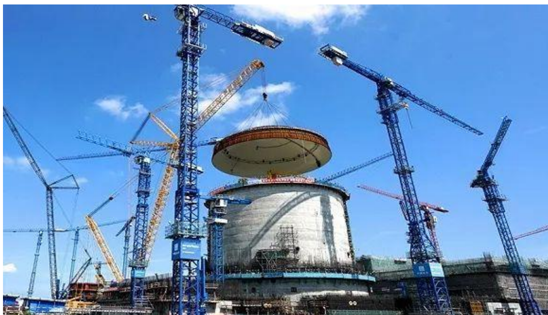
图为“华龙一号”施工现场（图片来源：视觉中国）。宝钢18MND5
