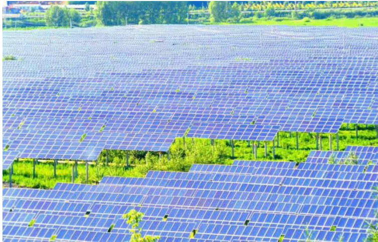
深能吉林白山农业光伏扶贫项目
