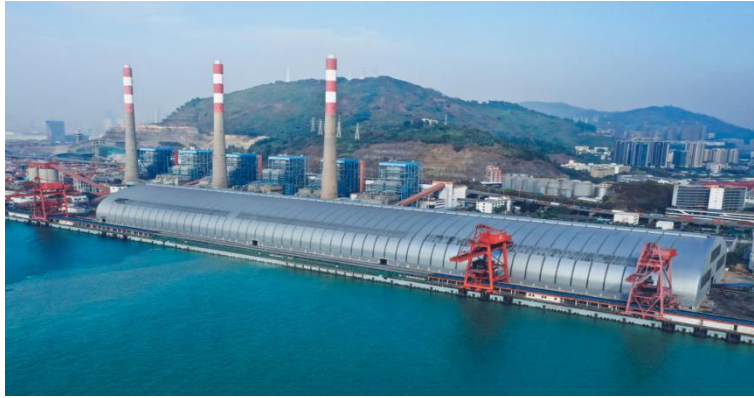
妈湾电厂煤场封闭完成实景图
