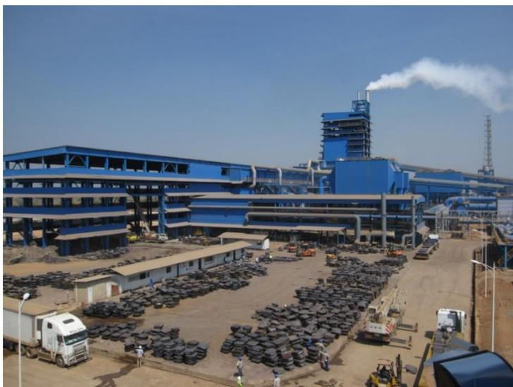
谦比希火法冶炼厂项目分为两期，一期项目设计规模为年产粗铜及阳极铜15万吨、硫酸40万吨，其于2006年正式开工，2009年竣工投产。二期项目于2014年完成扩建，粗铜及阳极铜年产能达到25万吨、硫酸达到70万吨。另外，谦比希火法铜冶炼厂还配套建设了多个综合回收项目，包括余热锅炉发电、电炉渣浮选回收铜、铋金属回收系统、钴金属回收系统。谦比希铜冶炼与北京矿冶科技集团合作研发铜钴合金产品，于2017年实现了销售收入，2017年、2018年各生产铜钴合金超1,000吨，其中含钴金属均超过100吨，2019年1-3月生产铜钴合金含钴20吨，3月开始，谦比希铜冶炼因铜钴合金生产系统改造升级，生产暂时停止。未来，谦比希铜冶炼还将立足于优化钴回收系统工艺，以提高其钴金属的综合回收率。
