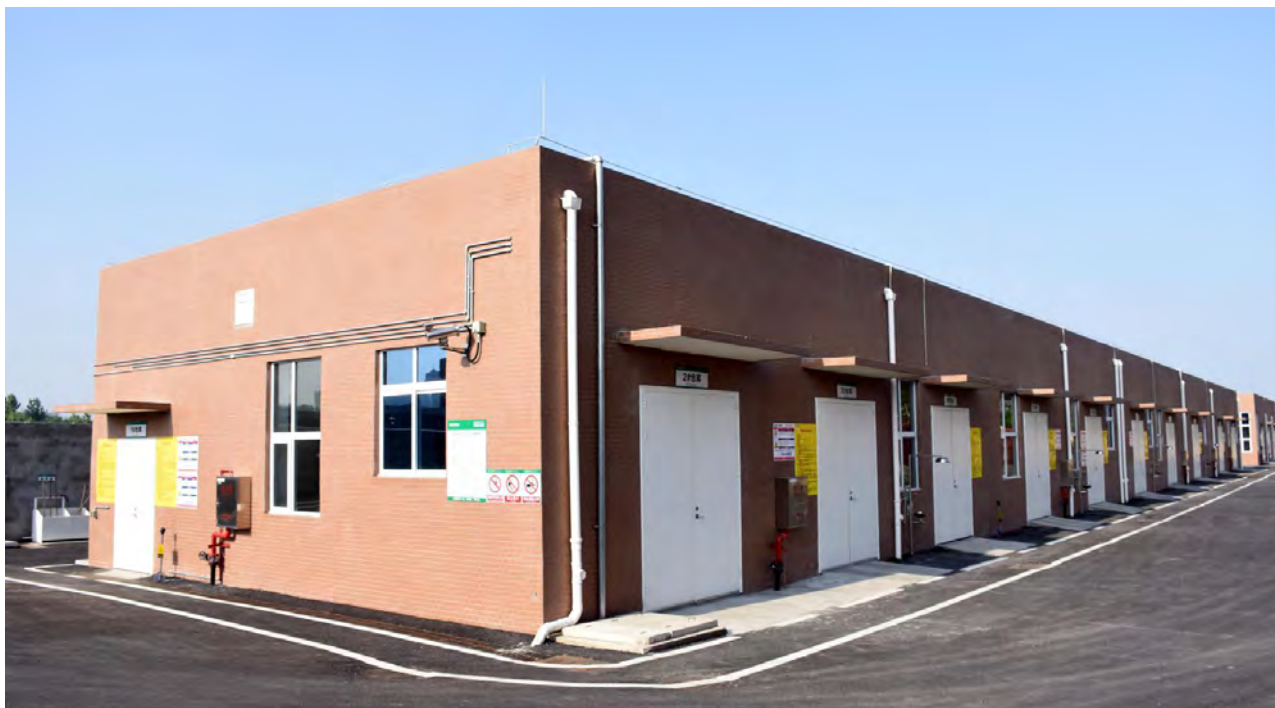
新建危险化学品仓库
