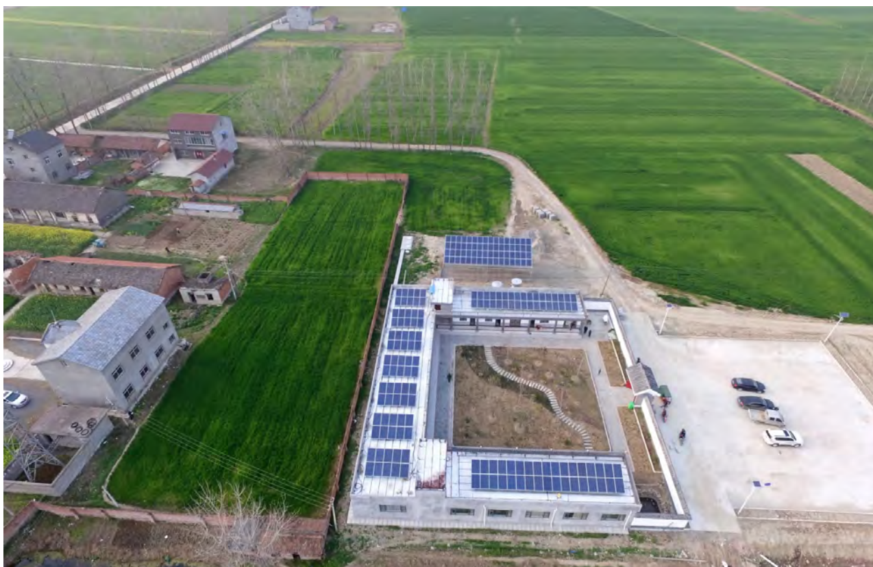
湖北省钟祥市柴湖镇凌楼村光伏储能项目
