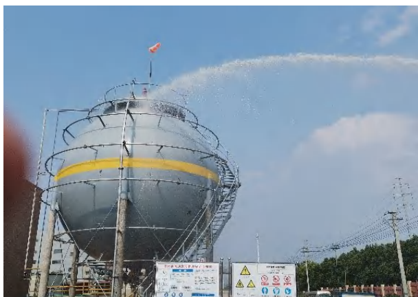
荆门园区消液氨罐消防演习
