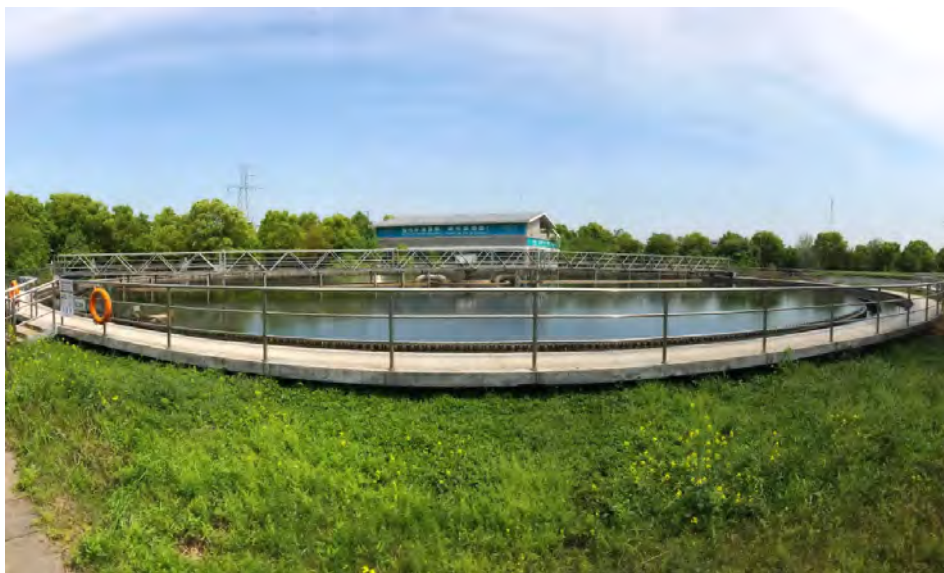
荆门高新区工业污水处理厂
