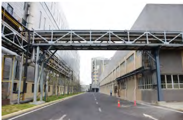
打通室外厂房间消防通道
