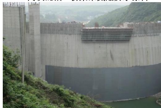
水坝工程防水
