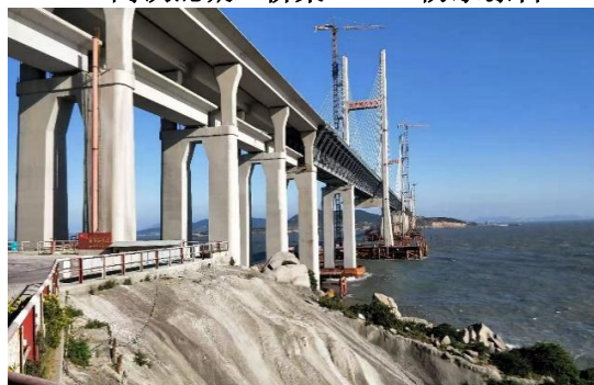
福平大桥工程防水
