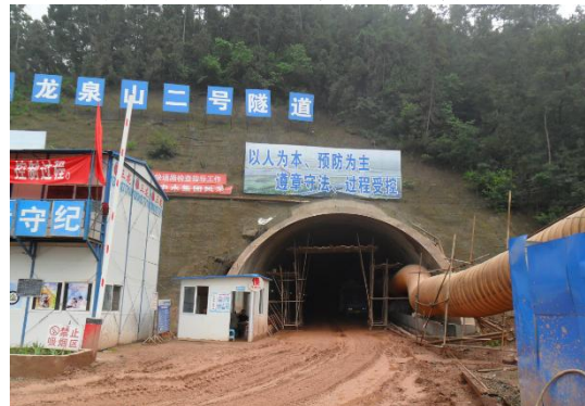
公路隧道工程防水
