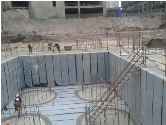
民用建筑防水施工
