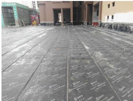
民用建筑防水施工
