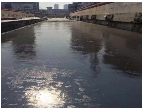
地铁站台顶板单组份聚氨酯防水涂料
