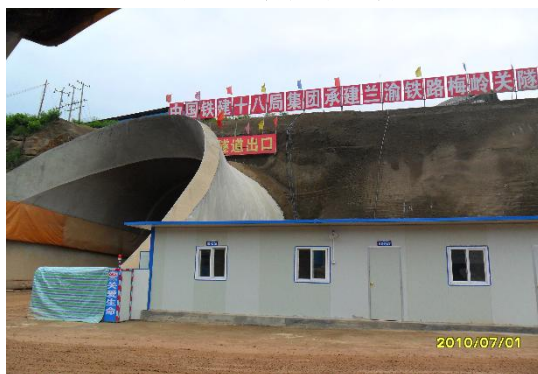
铁路隧道工程防水
