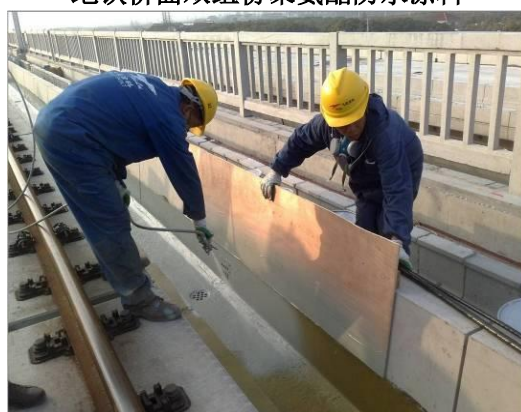
高铁混凝土桥梁聚氨酯防水涂料
