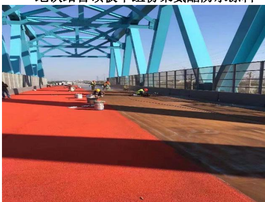
高铁混凝土桥梁 MMA 防水涂料
