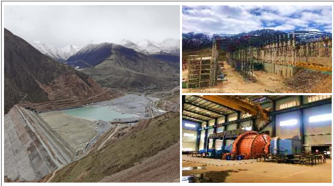
图：项目现场建设情况（在建的尾矿库、选矿厂等设施）
