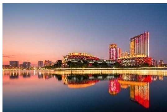
宁波镇海新城核心区亮灯工程
