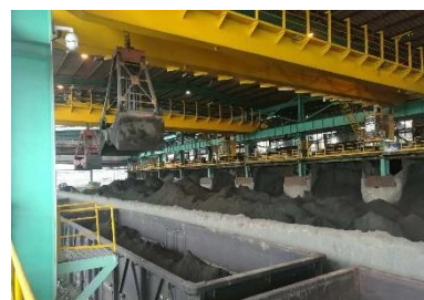
自动化-尾矿无人车现场作业
