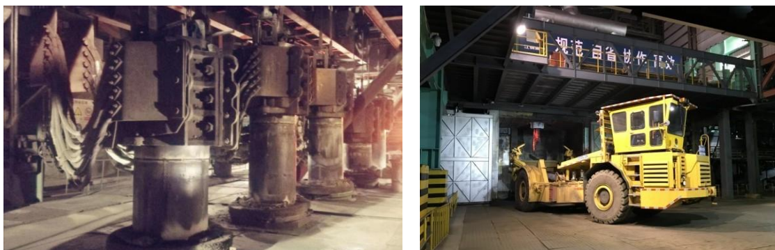
拆除贫化电炉前后对比图
