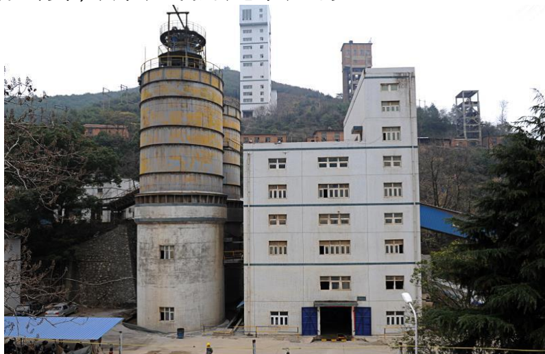
武山铜矿胶结充填站
