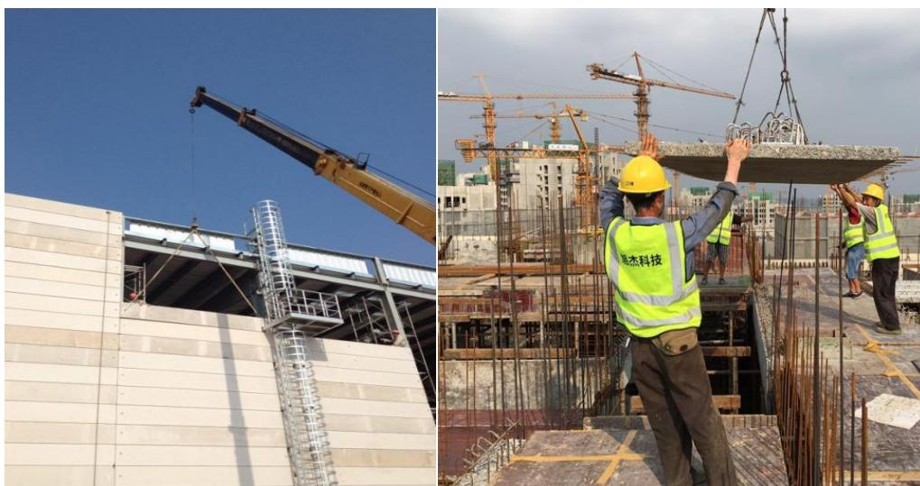
公司是国内较早引进、应用日本 ALC 预制装配式墙体技术的供应商。公司通过板材的专业排版、节点的深化设计和精细化的现场管理，公司在有效发挥 ALC 板材轻质、高强、平整、保温等特点的同时，缩短了项目现场施工周期，减少了材料资源的浪费和建筑垃圾的排放，符合现代建筑工业化、绿色节能的趋势。
