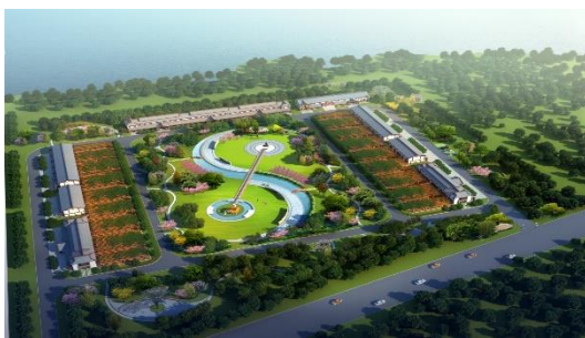
上图：连云港新城污水处理厂工程项目
