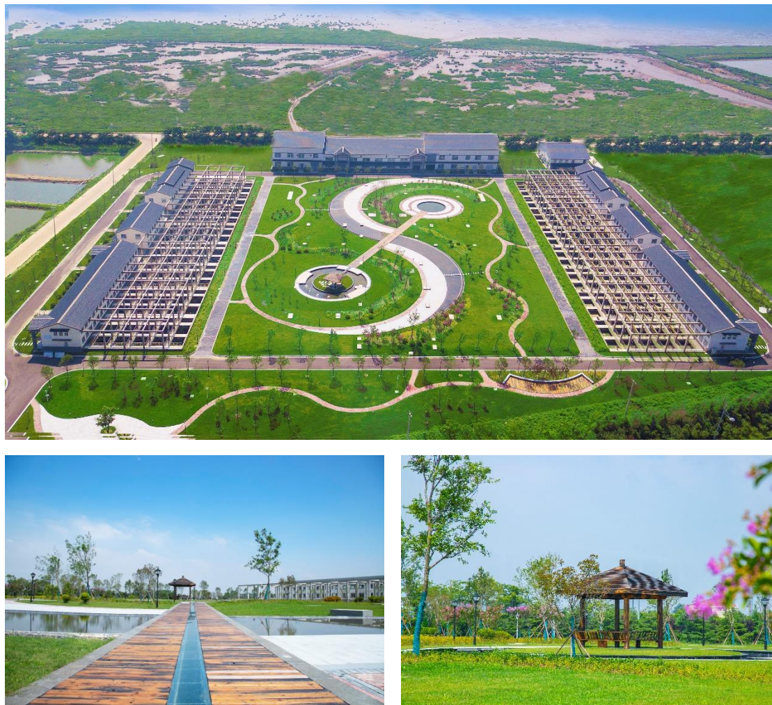
图 6-6 连云港市新城污水处理厂工程项目情况
