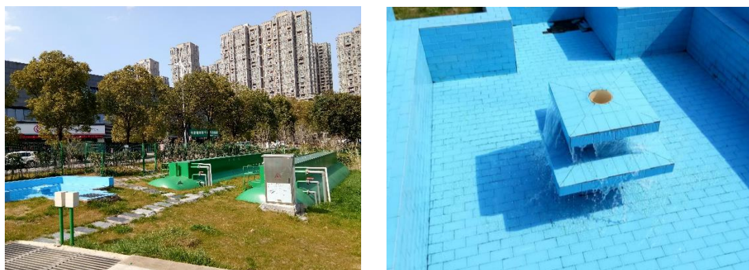
图 6-25 鲤鱼洲管理处生活污水处理项目情况
