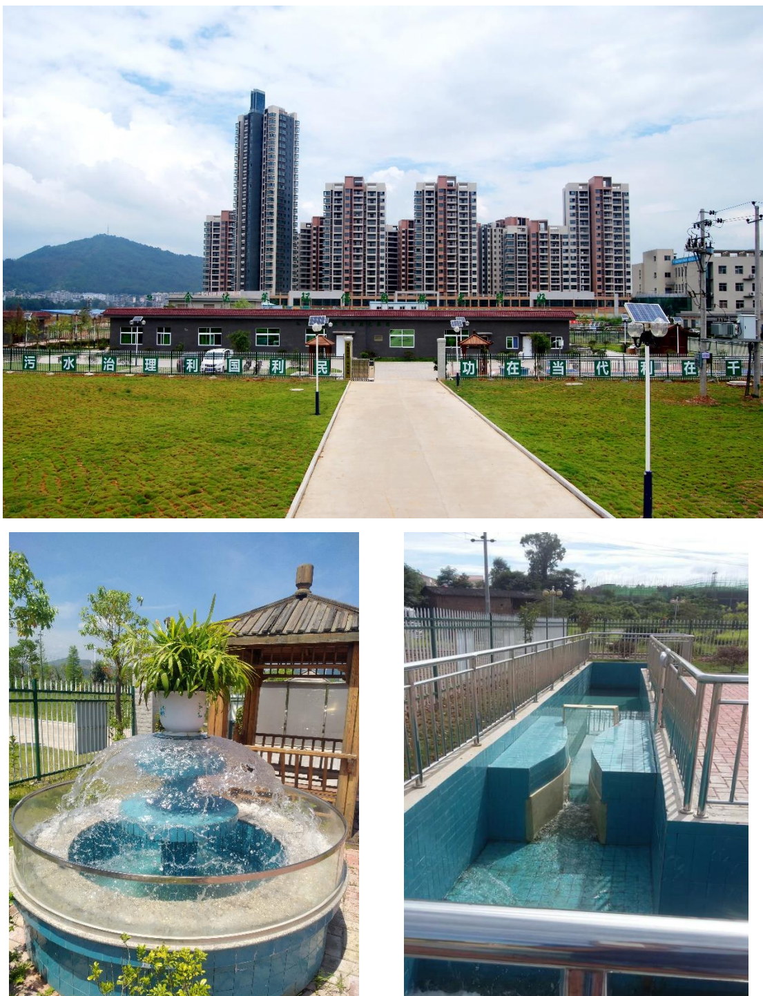
图 6-7 会昌县污水处理厂二期工程项目情况
