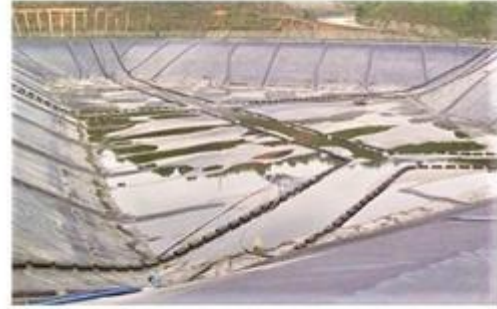
垃圾填埋场内渗滤液收集
