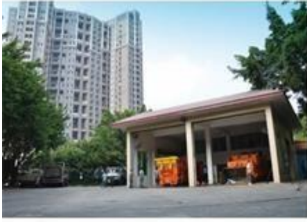
垃圾压缩中转站全貌
