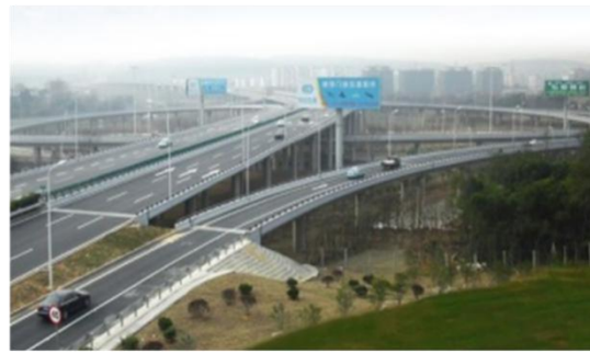
图例：武汉市解放大道江发立交桥 钢桁拱桥结构
