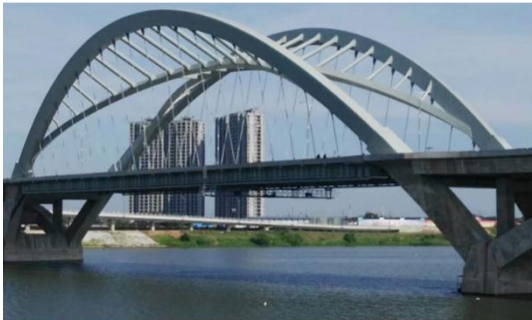
图例：鹰潭市余信贵大桥 钢管拱桥结构
