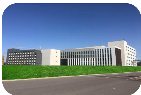
国际药物制剂生产线项目主体结构竣工验收
