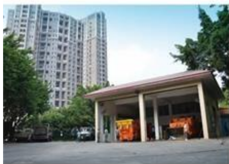
垃圾压缩中转站全貌
