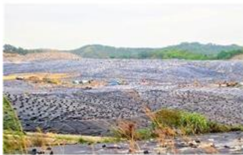
垃圾填埋覆盖
