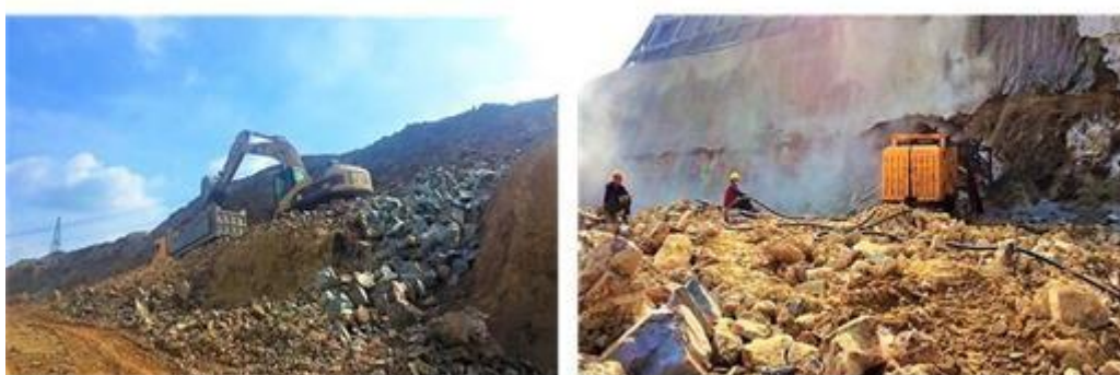
土石方开挖施工
