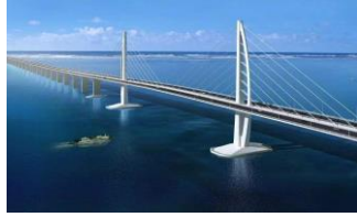
港珠澳大桥 GNSS 自动化形变监测系统
