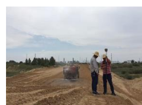
RTK 在道路施工放样中的应用
