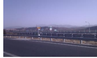
京承高速 边坡在线监测系统
