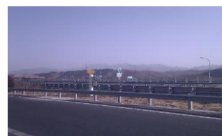
京承高速 边坡在线监测系统
