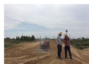
RTK 在道路施工放样中的应用
