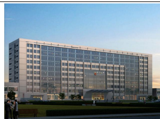
新疆克拉玛依市行政综合楼
