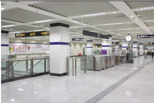
深圳地铁及所属物业 LED 照明改造项目
