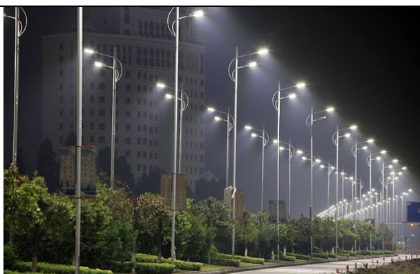
肇庆市高新区 LED 路灯节能改造项目
