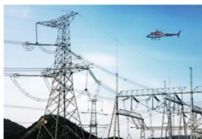
载人直升机巡检
