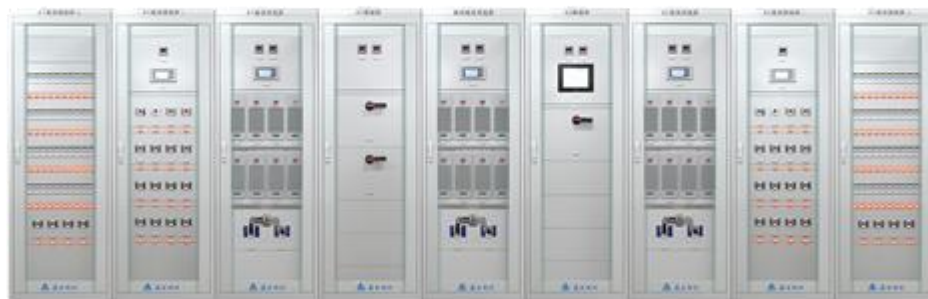
电力操作电源系统（一体化电源系统）
