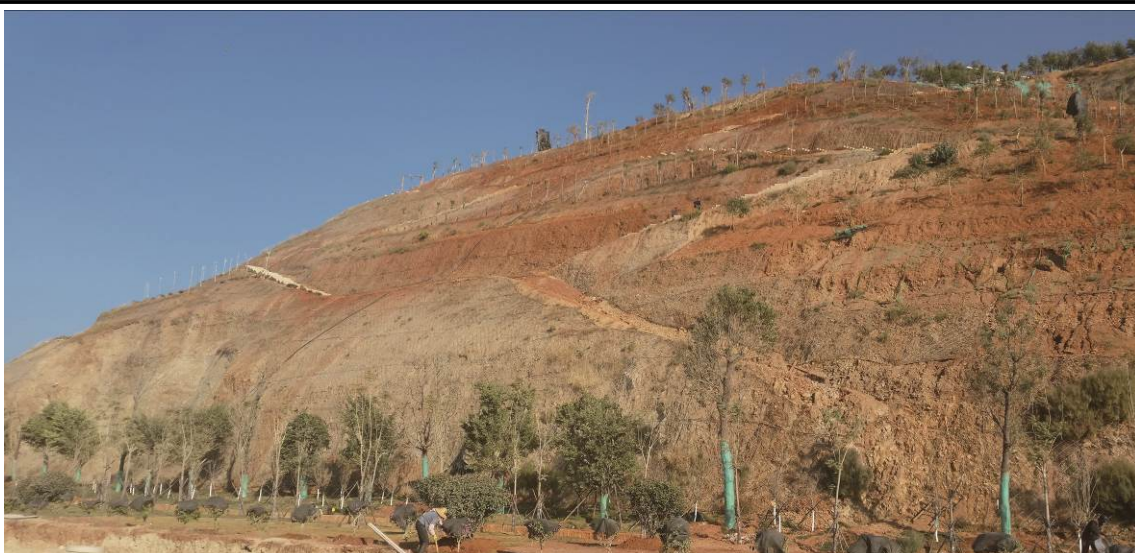
硬质岩石边坡（山东青岛，微风化、裂隙不发育裸岩边坡）
