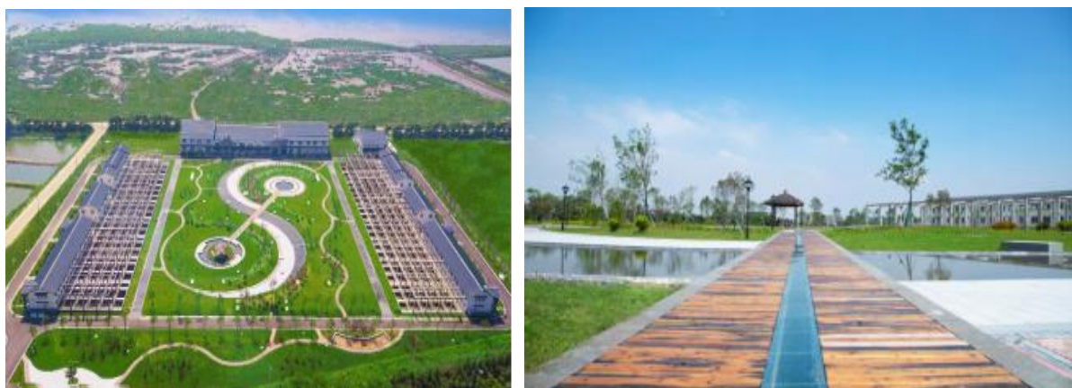
图为连云港市新城污水处理厂工程项目实景（共两期，总规模 13 万吨/天）
