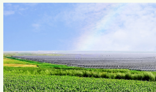
内蒙古兴安盟光伏电站项目
