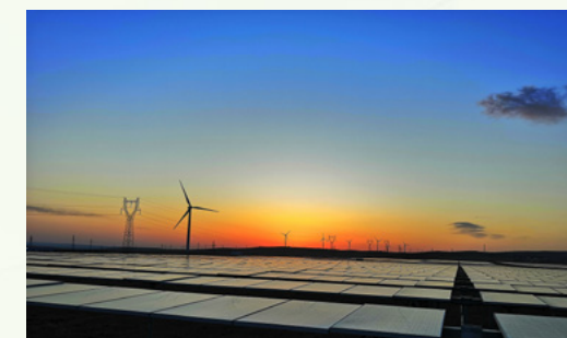
张家口市光伏电站项目
