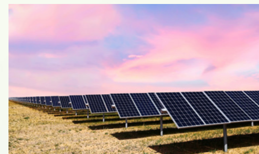
张家口市光伏电站项目
