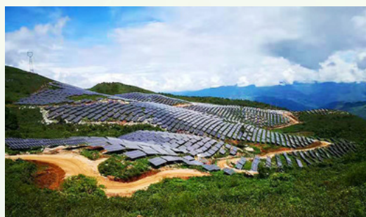
临沧市光伏电站项目
