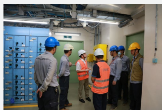
副总裁蒋达进赴大亚湾核电基地开展安全检查“回头看”
